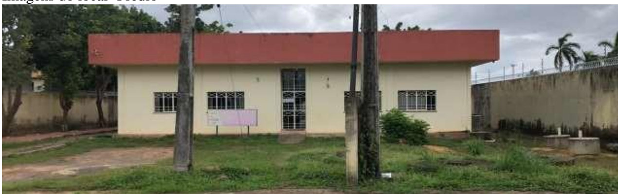
Imagens do local- Prédio
