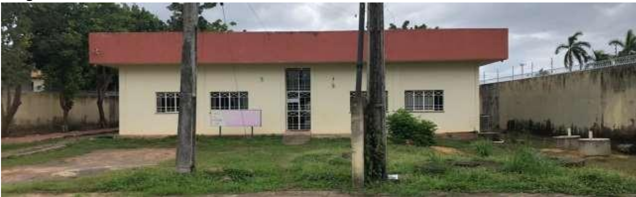
Imagens do local- Prédio
